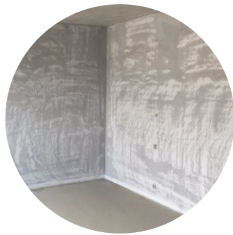
Beispiel: Backsteinwand mit Grundputz
